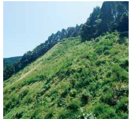
施工後1年6ヶ月
