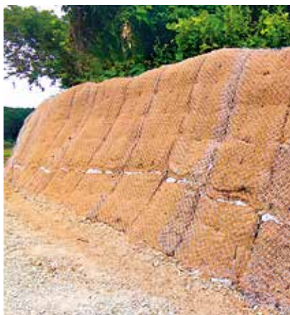
施工後(ひし形金網併用)
