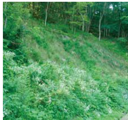
施工後1年4ヶ月
