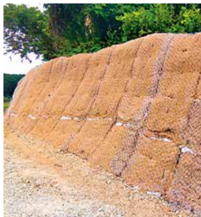
施工後(ひし形金網併用)
