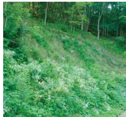
施工後1年4ヶ月
