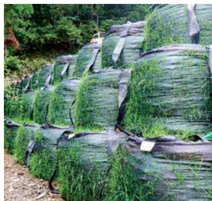
施工後約1ヶ月半
