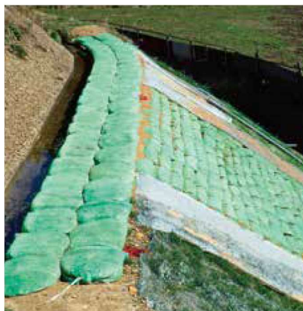
法面崩壊部分の埋戻し
