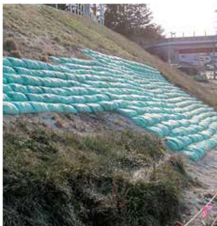
法面崩壊部分の埋戻し
