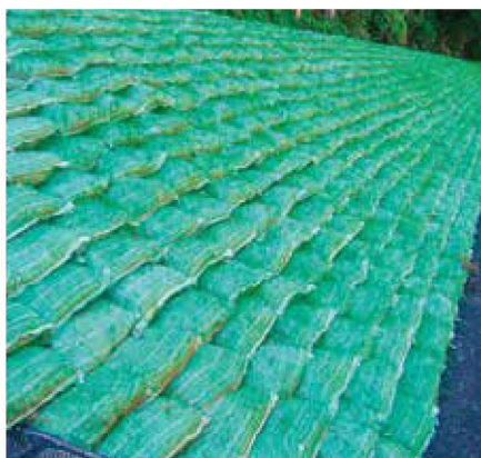
土留グリーンバッグ工
