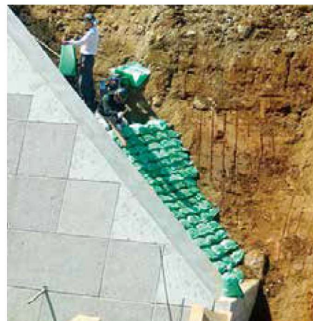
擁壁裏の土砂流出防止
