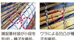
捕捉基材袋が小段を形成し、種子を捕捉。
