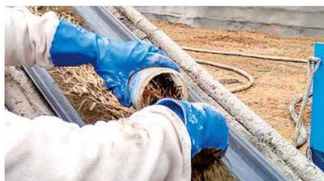
◎クラック防止を目的とする場合は1kg/m<sup>3</sup>、補強を目的とする場合は2kg/m<sup>3</sup>のバサロンファイバーを、モルタルやコンクリート吹付工の材料に添加してください。
