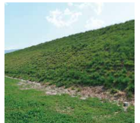
施工後1年2ヶ月
