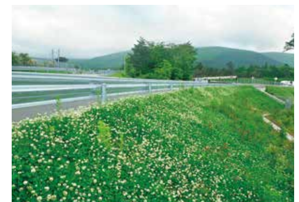
施工後1年2ヶ月
