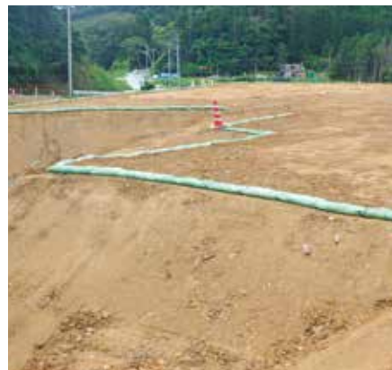
法肩まくらグリーンバッグ工
