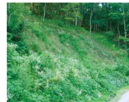
施工後1年4ヶ月
