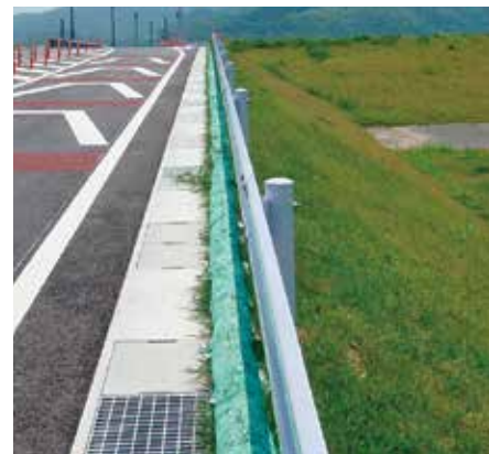
法肩まくらグリーンバッグ工
