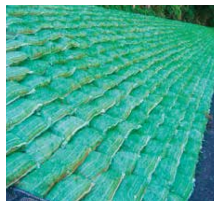
土留グリーンバッグ工
