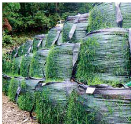
施工後約1ヶ月半
