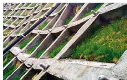
施工後5ヶ月半
