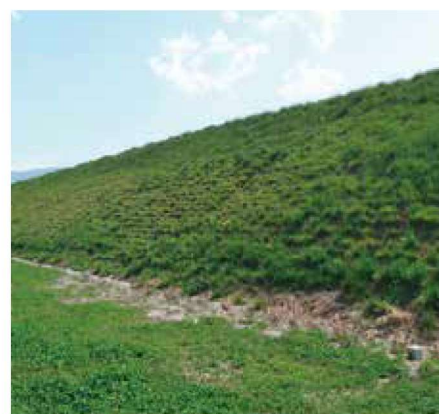
施工後1年2ヶ月
