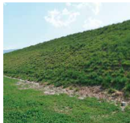
施工後1年2ヶ月
