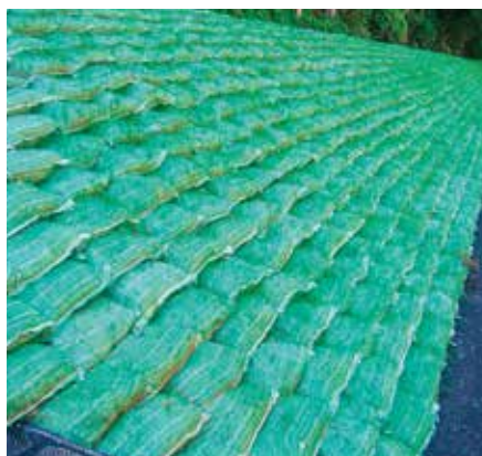
土留グリーンバッグ工
